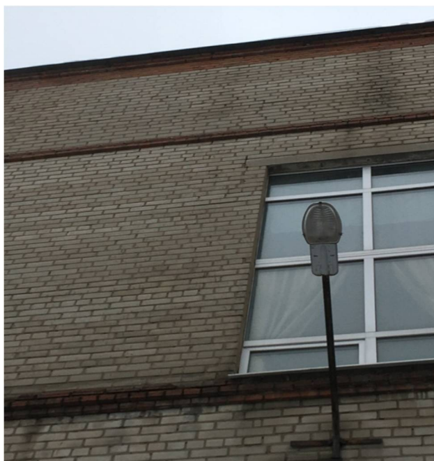
Рис. 1. Трещины, вызванные осадкой фундамента
