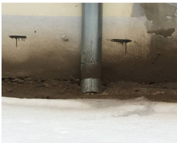
Рис. 3. Сброс атмосферных осадков по водосточной трубе на грунты
