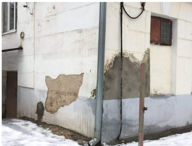
Рис. 4. Накопление конденсата в стене, трещины на фасаде, отслоение штукатурки фасада
