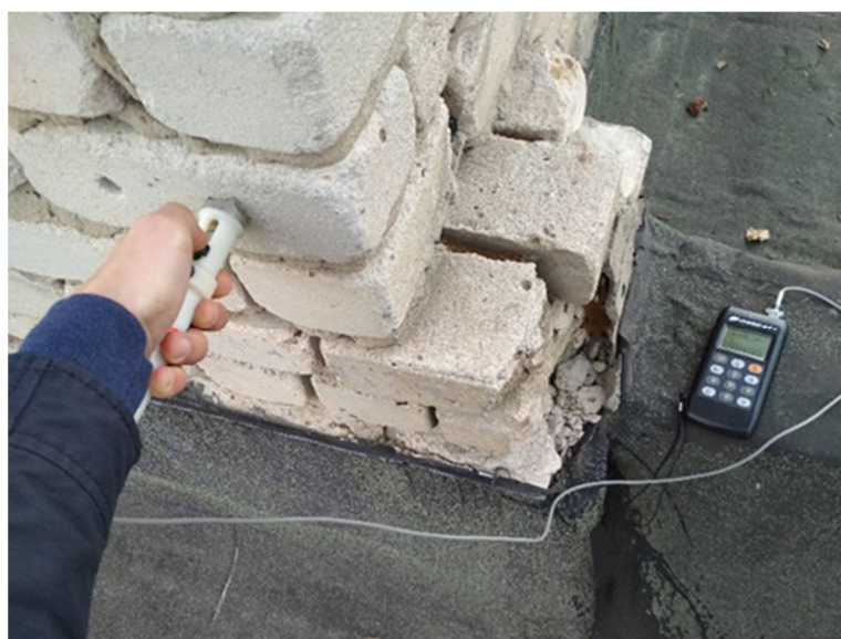
Рис. 5. Контроль прочности конструкции
