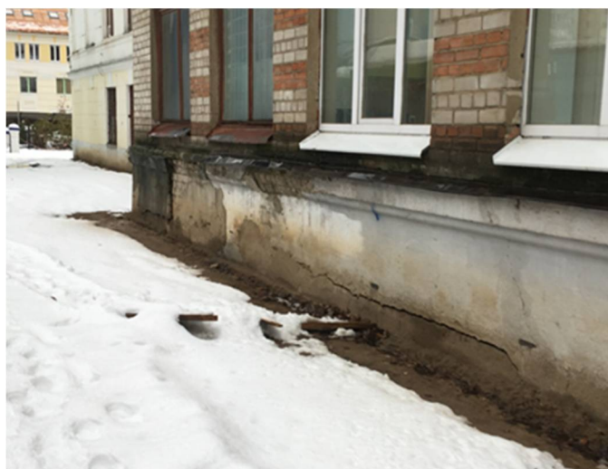
Рис. 2. Разрушение кирпичной кладки цоколя, отслоение штукатурки цоколя
